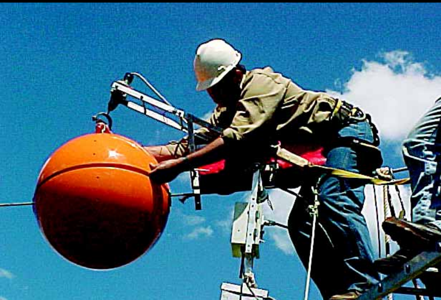
Esferas de sinalização foram instaladas em linhas energizadas com a ajuda de um robô desenvolvido por técnicos de FURNAS
