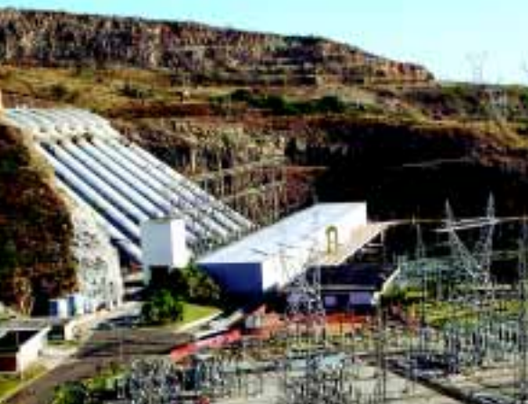
Vista geral da usina
